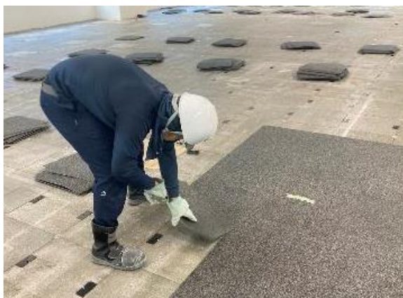
タイルカーペットの撤去状況
