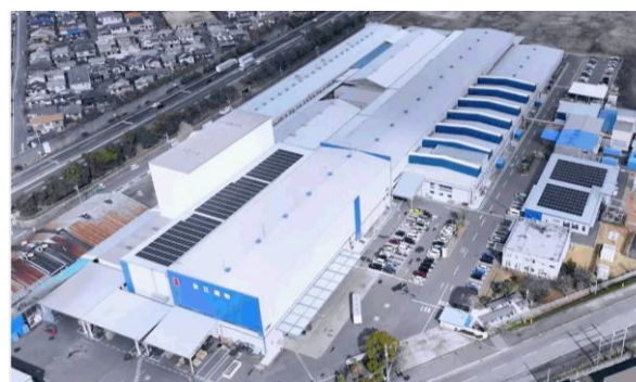
スミノエグループの再生タイルカーペット製造工場
